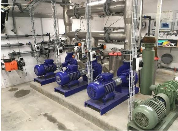
Die drei blauen **Umwälzpumpen** bedienen das Lehrschwimm-, das Springer- und 50 m-Becken mit gefiltertem, sauberem und erwärmtem Wasser. - Ein **Sandfilter** ist eine wichtige Komponente um die Becken mit sauberem Wasser beliefern zu können. Der **grüne Motor** dient dem Antrieb des Sandfilter-Gebläses.
