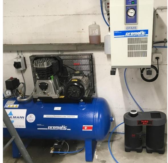
Sämtliche Ventile der Anlage sind elektronisch druckluftgesteuert. Dazu braucht es einen leistungsfähigen **Kompressor**.
