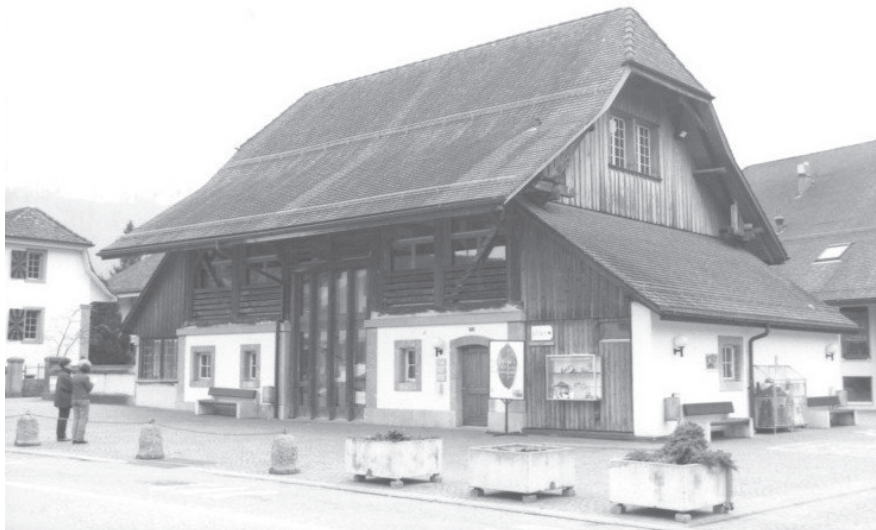
Abb. 11 Geschützte Pfrundscheune (Quelle: Bauinventar)
