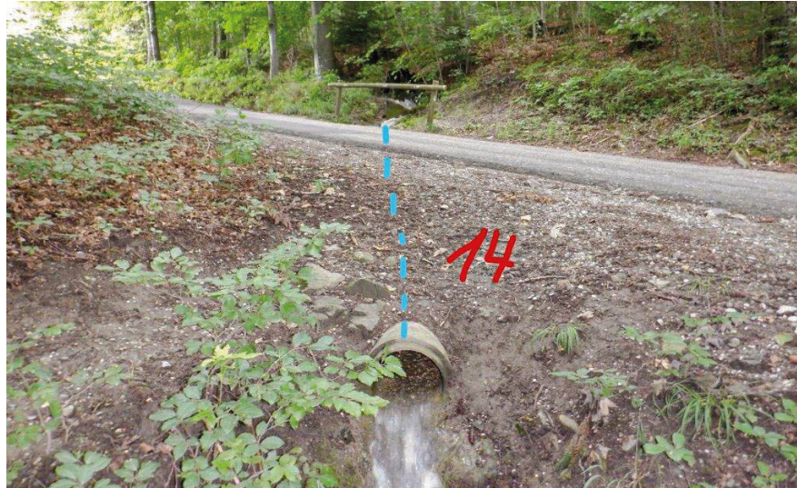
Abb. 12 Durchlass unter dem Zimmerwaldweg (Einleitung des Hofmattgrabe in den Hübeligrabe)
